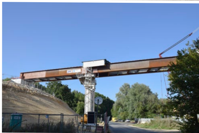
Aire de stockage des éléments du ponts
