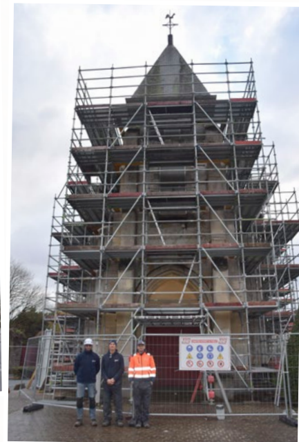
Pause photo des ouvriers qui ont installé ce monumental échafaudage par la société Léon NOEL chargée du ravalement de l'église.
